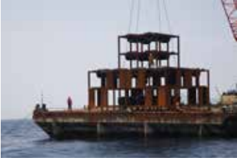
大型的鋼結構投放。
